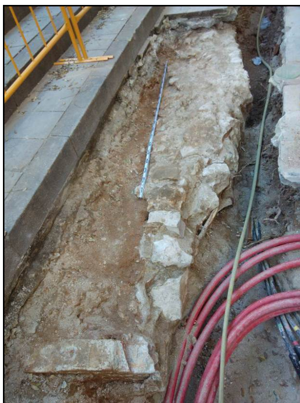
Fotografia 6. Detall del mur UE21 i al davant el mur de maó UE23.
